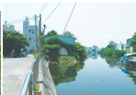
大崙儲水池護岸
