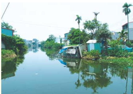
未改造前的大崙儲水池
