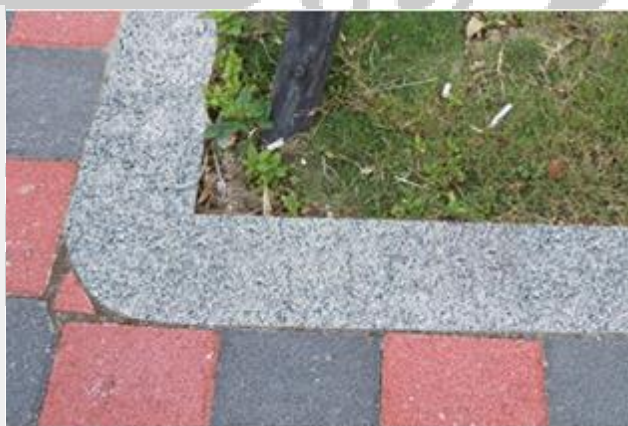
圖 3-35：高壓洗石子緣石鋪設成品
