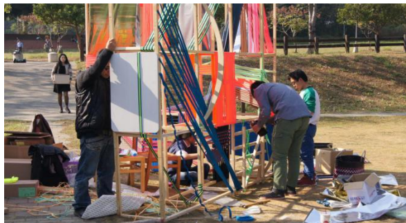
(圖 3.60) C14T-11(W-LR)《魔術方塊》由於分工製作,線繩拉力不同,導致傾倒。
