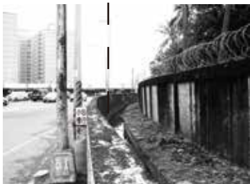
內圈外圍牆旁水溝環繞
