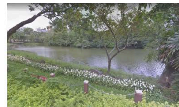
15消防蓄水設施
