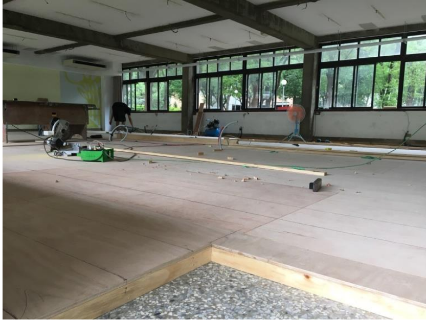
圖 3-9 線路配置完成後封板
