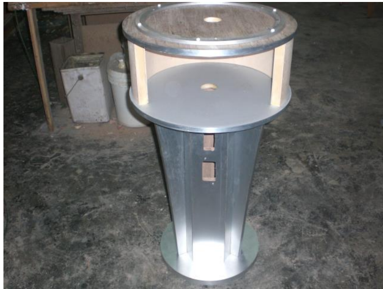
圖 3-1 教師桌施工中相片
