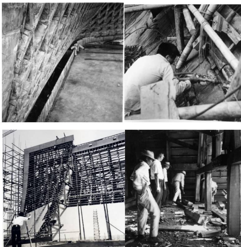
教堂施工照片
