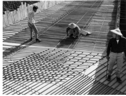
樓面鋼筋網綁
