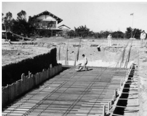
深掘了 2.2 公尺的地基
