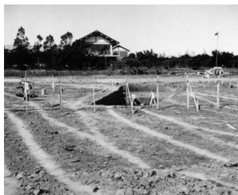
工人們挑著深掘後的土
