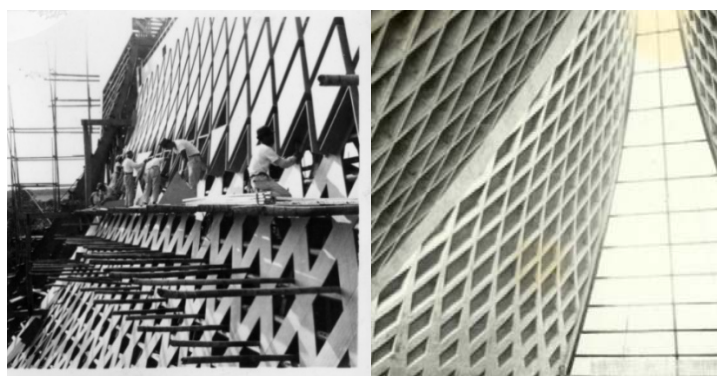
雙曲拋物面的格子樑柱牆合一結構
