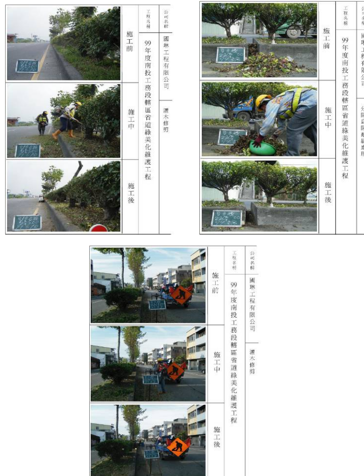
圖 1 99 年度南投工務段轄區省道綠美化維護工程施工照片(一)
