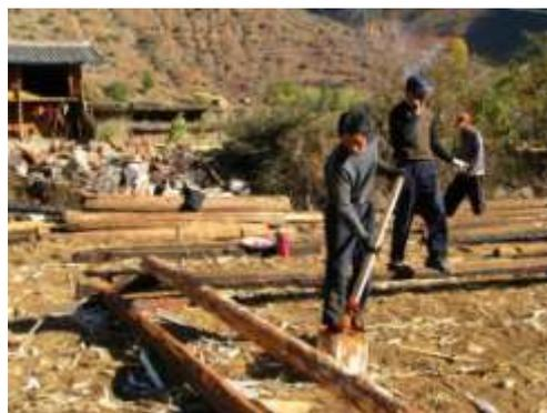
圖 146 在木楞子上塗上泥巴水確認木楞子的接合情形
