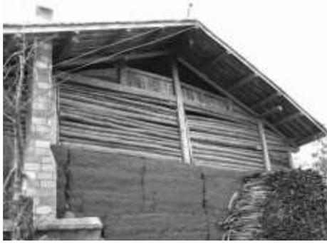
圖 138 外圍夯土牆上方的穿門式構架
