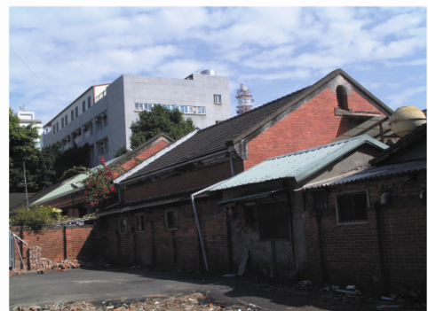
側邊全景--山牆上開有單拱形窗與灰泥帶狀裝飾。側立面多為增建。
