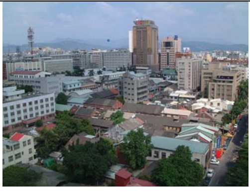
【圖 3-1 現況俯視照片】
