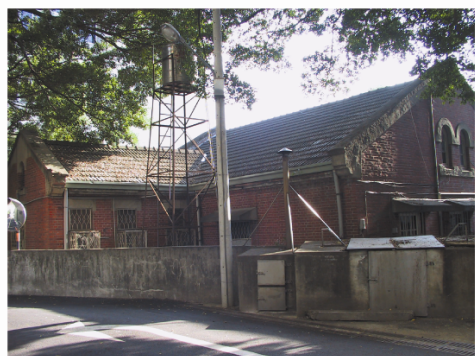
側邊立面--立面保存完整，山牆上開有拱形窗與灰泥帶狀裝飾。
