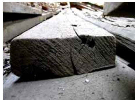
照片 2-38 日治時期之桷仔斷面為方整之矩形。(照片來源：寶元)
