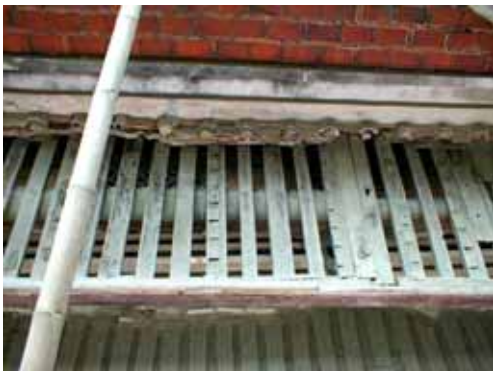
照片 2-25 正殿太子樓左側屋面使用舊構件作為桷仔使用情形。(照片來源：寶元)
