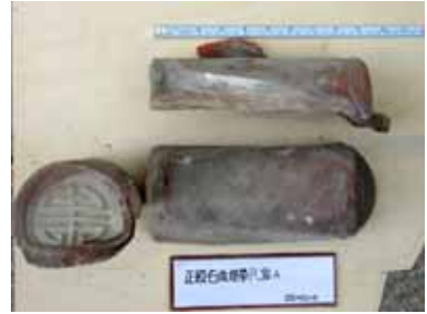
照片 3-37 施作於山牆上博風處之勾頭，飾紋頭起翹弧度較大，有將雨水拋出之功能。(照片來源：寶元)
