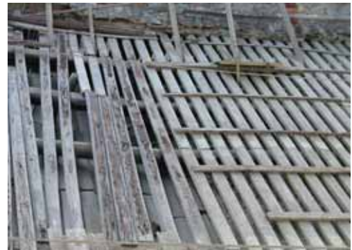
照片 2-43 照片中左側為舊桷仔，右側則為已 CCA 處理過的新製桷仔。(照片來源：寶元)
