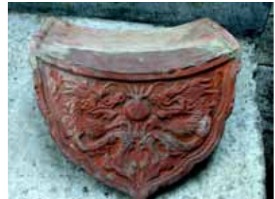
照片 3-40 機械製之滴水。(照片來源：寶元)
