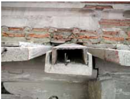
照片 2-29 屋面以槽型鋼補強情形，槽型鋼下方式視覺可見之處仍以木料包覆。 (照片來源：賈元)
