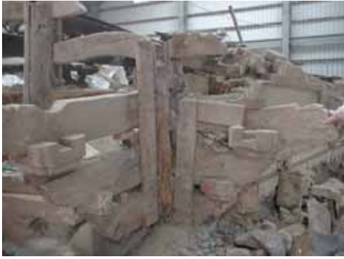
照片 2-12 正殿左後側四路後附點金柱，於七十五年時修補情況。(照片來源：寶元)
