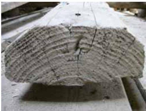
照片 2-33 正殿暗厝間桷才斷面年輪即可判斷出，將原木斷面分成三等份切割製成。 (照片來源：寶元)
