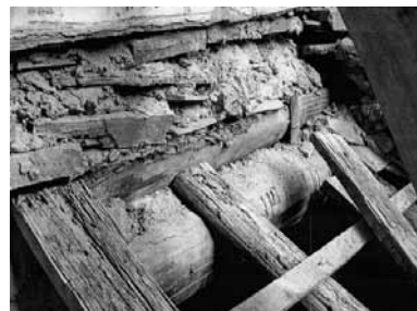
照片 2-21 正殿暗厝間中脊樑近似扶脊木之作法。(照片來源：寶元)
