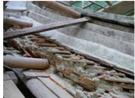
照片 3-10 太子樓左前側於日治時期重新施作土灰層，最上層板瓦則於民國五十年重新鋪設。(照片來源：寶元)
