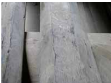
照片 2-31 暗厝間桷才表面留有早期工人以手斧施工痕跡，因呈現出凹凸不平之修整面。（照片來源：寶元）
