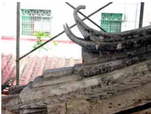
照片 3-24 昭和十一年后殿右側歸帶與屋面交接處，笑瓦之構成方式，為「壓七露三」的作法。(照片來源：寶元)
