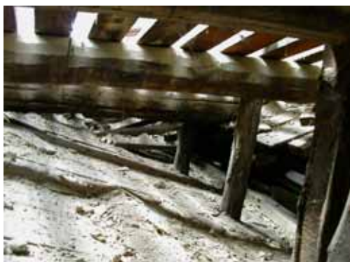
照片 2-5 龜背內短木柱與楹仔搭接方式，咸豐年間無支撐短木柱，應於日治時期所增加。（照片來源：寶元）
