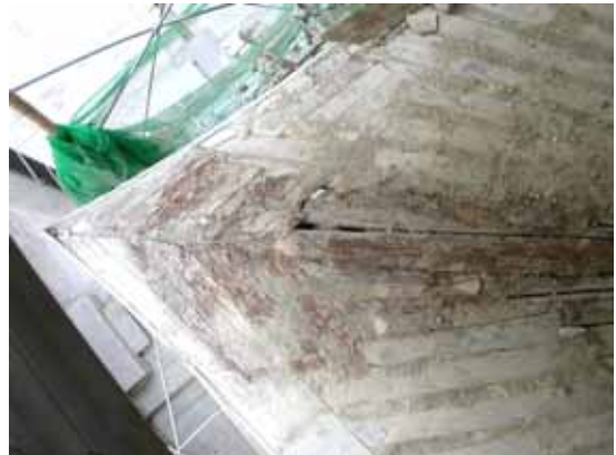
照片 2-42 正殿下層檐左後翼角養仔板鋪設排列方式，翼角前端以橫養仔板做修補，其餘位置仍為順養仔板。(照片來源：寶元)
