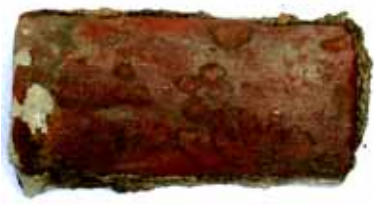
照片 3-35 筒仔瓦上留有清楚的手掌痕跡。(黃曉雯提供, 為丁宅之筒瓦)
