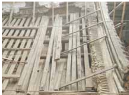
照片 2-19 正殿前屋坡暗厝間新舊桷仔分佈情形。(照片來源：寶元)
