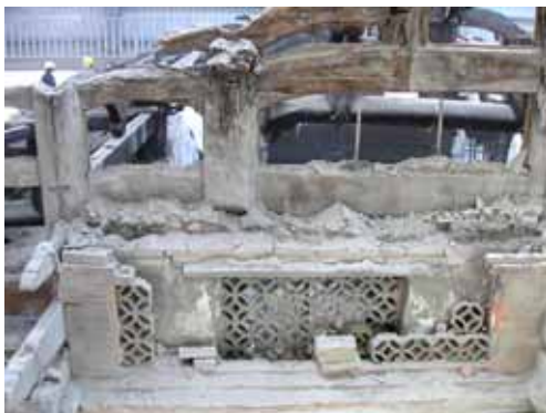
照片 2-3 正殿左右側重檐間牆有內外兩層不同時期築砌的痕跡。(照片來源：寶元)
