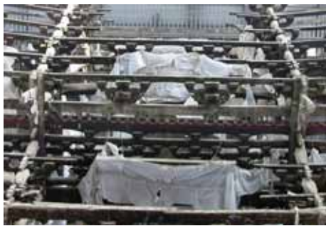
照片 2-22 正殿前側明間刻有凹槽之木構件為七逃樑。(照片來源：寶元)
