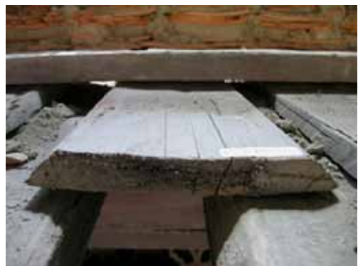
照片 2-45 手工製作之養仔板斷面為不規則形狀。(照片來源：寶元)
