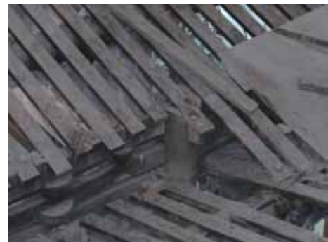
照片 2-24 拜亭與正殿下層檐桷仔搭接方式，以一約 12 cm×18 cm 之矩形斷面木料，並依桷仔搭接位置上施作深 3 cm 的凹榫。(照片來源：寶元)
