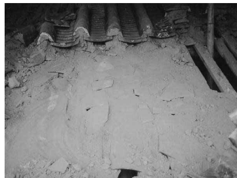
照片 2-49 鹿港丁宅屋頂桷仔上鋪設碎瓦層，碎瓦上再以石灰覆蓋後鋪屋面瓦。(黃曉雯拍攝。)
