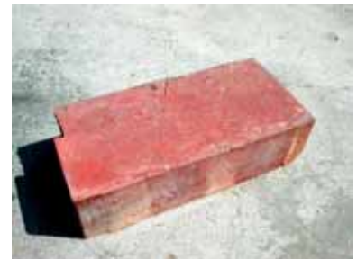
照片 3-48 機械製磚表面無切割線，且留有自動磚機的施作痕跡。
