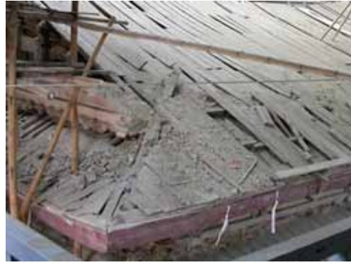
照片 2-13 於太子樓左後翼角七十五年時以槽型鋼加固情況。(照片來源：寶元)
