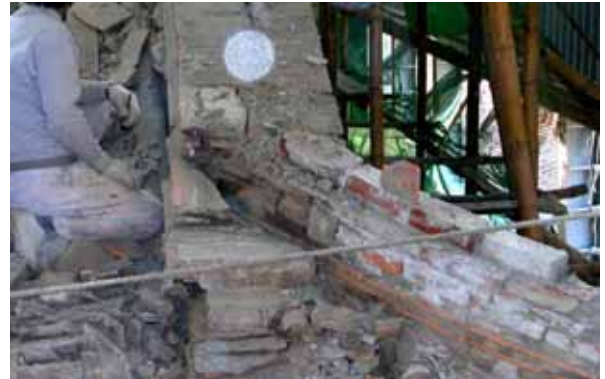
照片 3-53 右後串角脊與歸帶交接處之構築情形。(照片來源：寶元)
