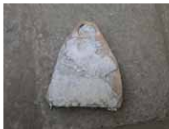
照片 3-77 後側重檐間牆文字堵以麻絨灰泥填滿於交趾陶片內。(照片來源：寶元)
