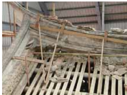
照片 3-5 后殿中脊與歸帶交接處約 25 公分厚之土灰。(照片來源：寶元)
