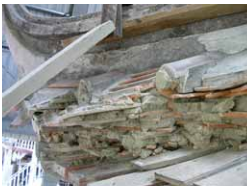
照片 2-51 道光年間正殿下層檐左後翼角翼角起翹之構成方式。(照片來源：寶元)
