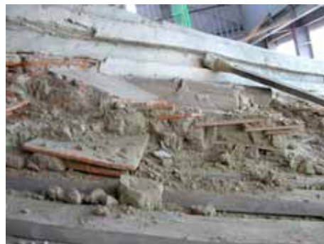
照片 3-8 正殿下層檐土灰層之構成，下方為清領時期以手工施作之養仔板。(照片來源：寶元)
