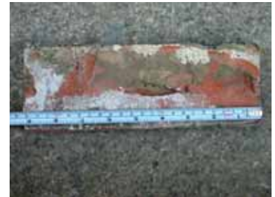
照片 3-43 使用於龍山寺左右側山牆之斗子砌面磚。(照片來源：寶元)
