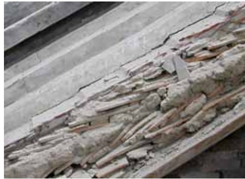
照片 3-27 正殿右前歸帶與屋面交接處，第一層為民國七十五年以「疊二」的方式修補。 (照片來源：寶元)
