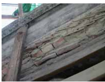
照片 3-12 后殿土灰層材料質構成。(照片來源：寶元)
