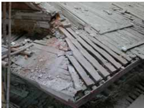
照片 2-53 太子樓右前翼角翼角起翹之構成。(照片來源：寶元)
