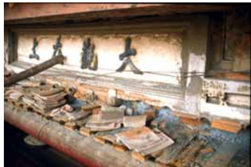
照片 2-30 七十五年修護時抽換重檐間牆至二架楹間的桷仔，並於重檐間牆與桷仔間以混凝土添補。( 洪文雄 老師於七十五年修護時所拍攝)
