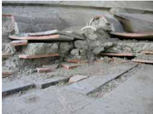
圖 3-20 清領時期正殿下層檐左後串角脊筒板瓦之構成。(照片來源：寶元)
