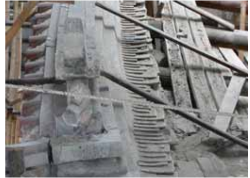
照片 3-23 明治年間正殿左側歸帶與後屋面交接處，以「蜈蚣腳」的作法鋪瓦。(照片來源：寶元)
