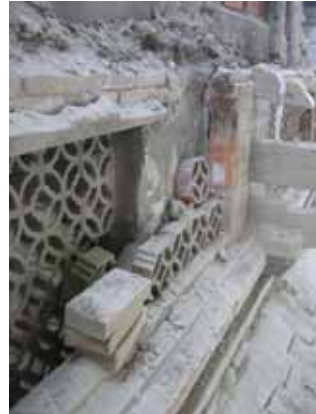
照片 3-54 右側重檐間牆外層為手扒磚。 (照片來源：寶元)
