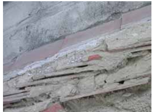
照片 3-29 民國七十五年后殿左後歸帶旁以「疊二」的作法修補。(照片來源：寶元)
