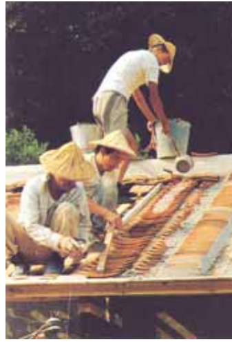
照片 3-16 照片中為瓦匠鋪完瓦之後，以水測試瓦是否有順直，此一動作稱之為試水。(取自 李乾朗《傳統建築入門》1984 p.40。)
