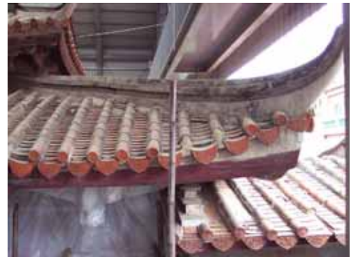
照片 2-50 正殿下層檐翼角翼角起翹之形式。(照片來源：寶元)
