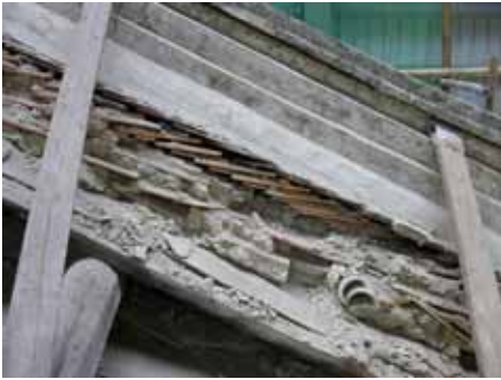
照片 2-40 暗厝間桷仔上所鋪設即為叩瓦。 (照片來源：寶元)
