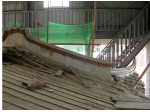
照片 3-3 拜亭屋面與暗厝間搭設關係。(照片來源：寶元)
