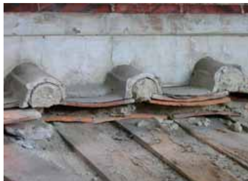
照片 3-31 拜亭側屋面博脊下出瓦構成情形。 (圖面來源：寶元)
