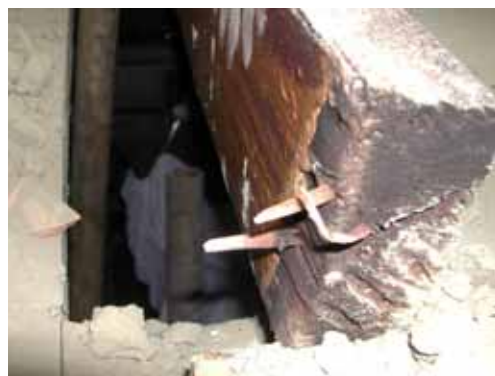
照片 2-36 龍山寺使用之竹釘長度約桷仔厚度的 1.5 倍。(照片來源：寶元)
