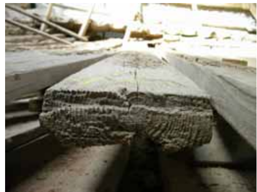
照片 2-34 由正殿暗厝間桷才斷面年輪即可判斷出，原應爲一斷面較小之原木，將之對剖而成。(照片來源：寶元)
