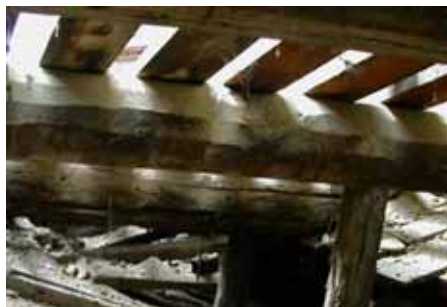
照片 2-7 龜背左側楹仔表面手鋸之施工痕跡。(照片來源：寶元)
