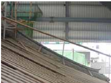
照片 3-4 后殿土灰層屋面成一凹球形曲面。(照片來源：寶元)
