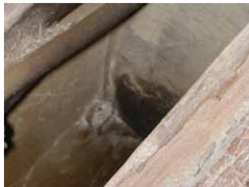
照片 2-11 后殿於楹仔下坡處置一竹子以固定楹仔。(照片來源：寶元)
