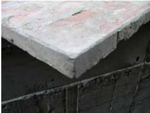
照片 3-44 尺磚四周於燒製完成後，再以人工將之修飾成近四十五度角。(照片來源：寶元)
