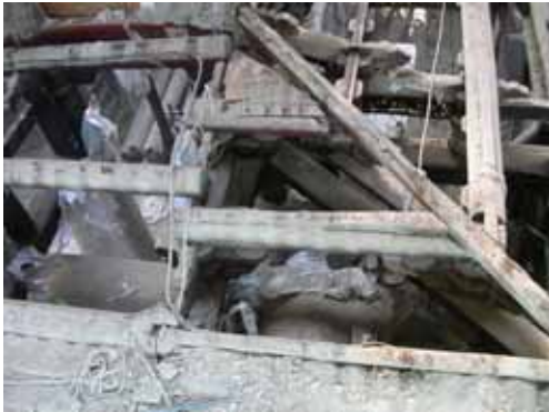
照片 2-4 右前側下層檐翼角楹仔構成方式。 (照片來源：賈元)
