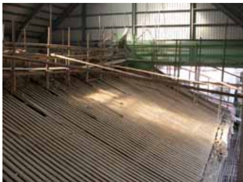
照片 2-27 后殿後屋坡桷仔鋪設情形。 (照片來源：寶元)
