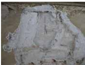
照片 3-76 後側重檐間牆文字堵以竹筆沾墨在預貼位置上做記號。(照片來源：寶元)
