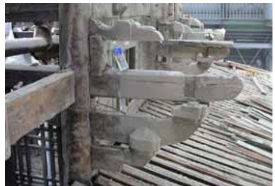
圖 4-18 正殿右側重檐間草尾拱因增建下層博脊而部分切除。(照片來源：寶元)
