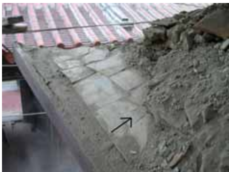
照片 3-7 箭頭所指為正殿下層檐左後翼角落架過程中發現「泉瓦」的位置。(照片來源：寶元)
