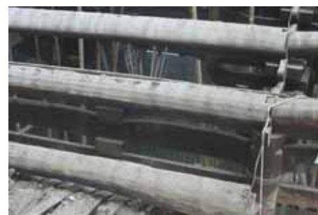
照片 2-8 后殿步口捲棚頂上暗厝間內之楹仔。(照片來源：寶元)
