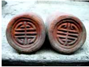
照片 3-36 照片左側為正確勾頭之飾紋方向，右側則為上下相反之勾頭飾紋。(照片來源：寶元)
