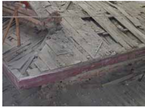
照片 2-55 太子樓左後翼角翼角起翹之構成，翼角串桷七十五年時以槽型剛補強。(照片來源：寶元)
