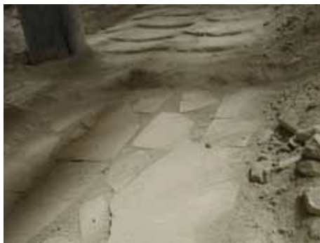
照片 2-48 正殿暗厝間於養仔板上鋪設碎瓦的情形。(照片來源：寶元)
