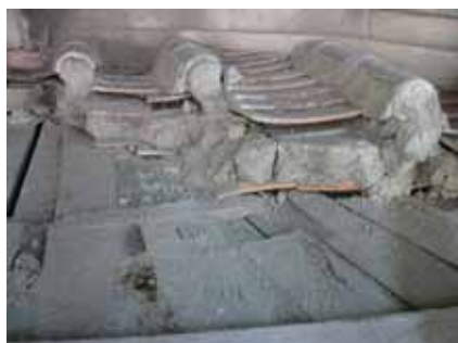
照片 3-11 日治時期鋪設之土灰層。(照片來源：寶元)
