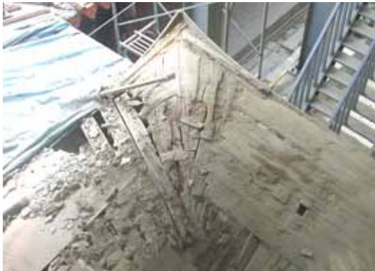
照片 2-41 正殿下層檐左前翼角養仔板鋪設排列方式，仍保留始建時期放射狀鋪法，照片右側為日後修補之橫養仔板。(照片來源：寶元)
