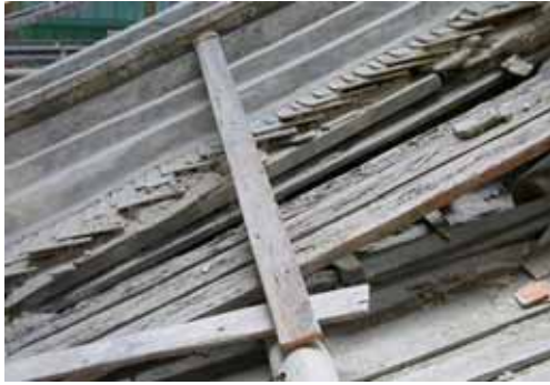
照片 3-22 明治年間正殿左側歸帶與後屋面交接處，笑瓦之構成方式，為「疊五」的作法。(照片來源：寶元)
