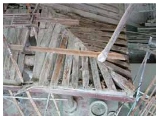
照片 2-52 拜亭翼角上下層桷仔之作法。(照片來源：寶元)
