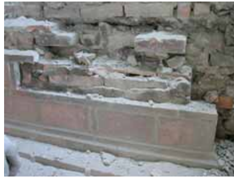
照片 3-55 左側重檐間牆外層為斗子砌面磚。 (照片來源：寶元)
