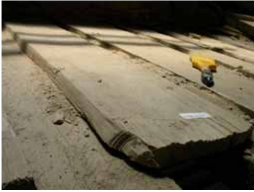
照片 2-46 日治時期以手工鋸子裁切之養仔板，端部為材料未完全鋸開而硬將它剝開所留下的痕跡。(照片來源：寶元)
