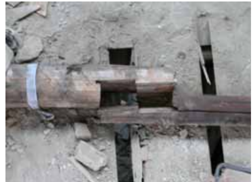
照片 2-6 太子樓左側挑檐楹對接樁頭樣式。(照片來源：寶元)
