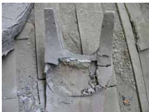
照片 3-56 日治時期歸帶草尾內放置 U 形銅線。(照片來源：寶元)
