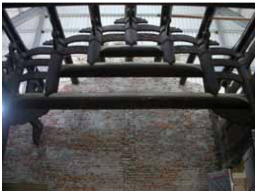
照片 2-10 后殿次間四路為童柱式疊斗棟架。(照片來源：寶元)
