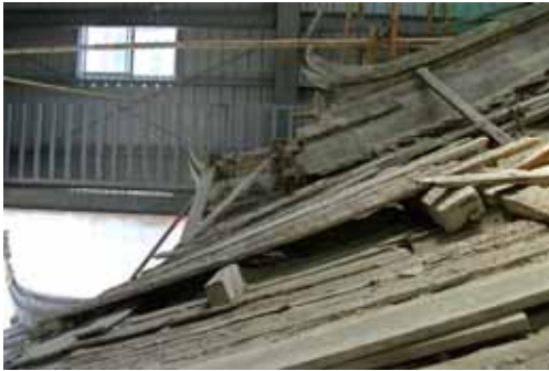
照片 3-9 太子樓左後側於日治時期施作暗層間以減輕屋頂荷重。(照片來源：寶元)
