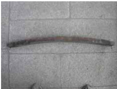
照片 2-23 拜亭彎桷仔乃由一完整木料將其曲度放樣後裁切而成。(照片來源：寶元)
