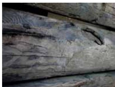
照片 2-32 暗厝間手工桷仔表面仍留有樹的結疤情形。（照片來源：寶元）
