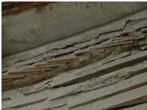
照片 3-28 民國七十五年拜亭左後歸帶旁以「疊二」的作法修補。(照片來源：寶元)
