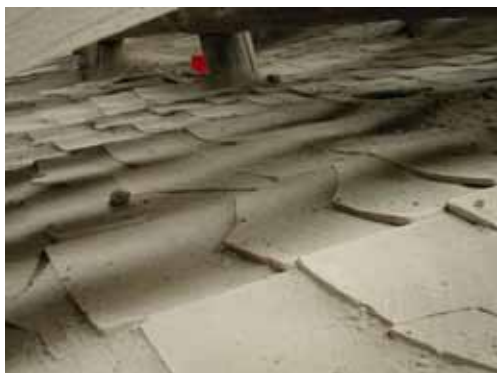
照片 3-18 正殿暗厝間內笑瓦排列方式。 (照片來源：寶元)
