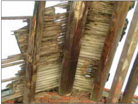
照片 2-39 鹿港日茂行以竹子做為桷仔使用，首先將竹子對剖，半圓曲面朝下，以密集方式排列。
