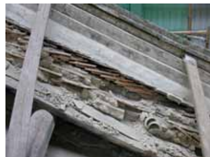
照片 3-13 太子樓左前側屋坡土灰層材料之構成。(照片來源：寶元)
