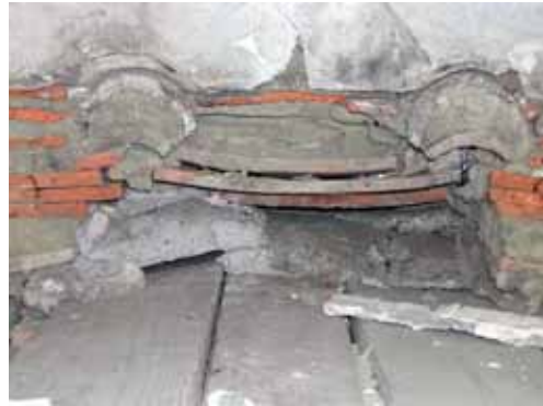
照片 3-21 清領時期太子樓右屋坡筒板瓦之構成，照片中央為七十五年修補之混凝土。(照片來源：寶元)
