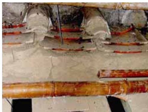
照片 3-30 中脊下之出瓦構成情形。 (照片來源：寶元)
