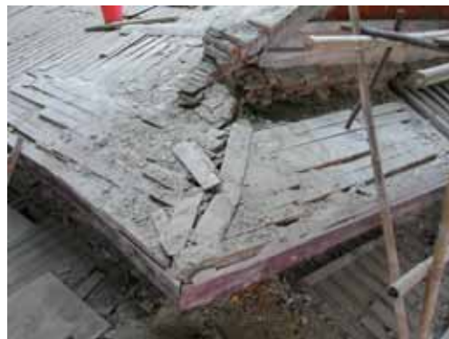
照片 2-54 太子樓左前翼角翼角起翹之構成。(照片來源：寶元)
