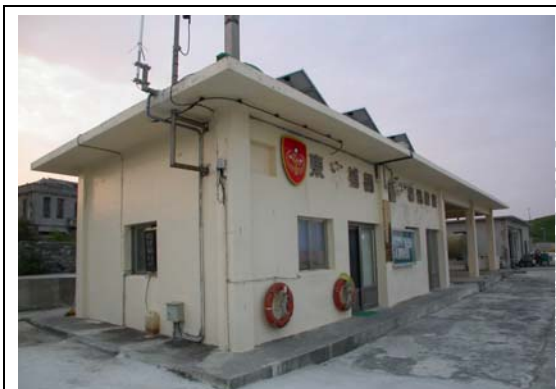
照6-2-3.9 東吉嶼設置安檢所 <資料來源：本研究攝於東吉， 2010.03.24 >
