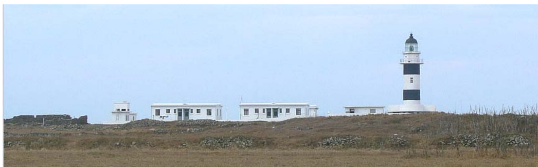
照5-1-3.3 東吉嶼燈塔 <資料來源：國家文化資料庫>
