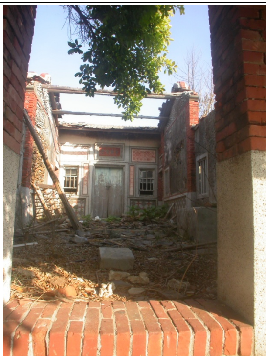
照5-1-3.10 東吉嶼南邊49號古厝之 「一落四櫺頭」 〈資料來源：旅居台南東吉人鄭明 成先生提供〉
