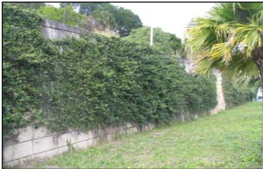
圖 2-2-5 牆面直接下垂型（省道 74 線）
