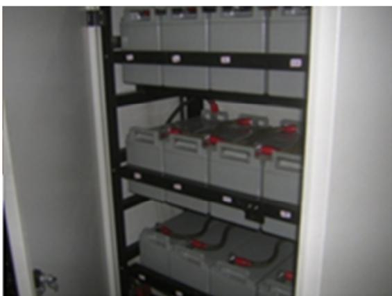
圖 3-5 科技廠房不斷電系統設備
