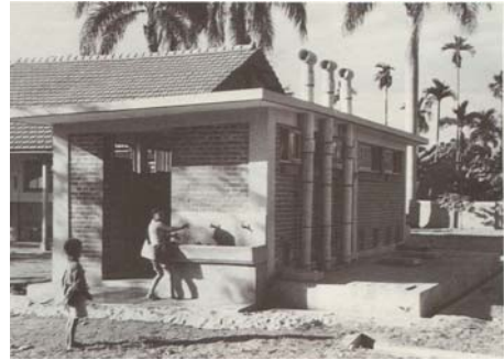
圖【3-8】國民小學沖水式廁所 資料來源：行政院衛生署 1995《台灣地區公共衛生發展史（二）》。
