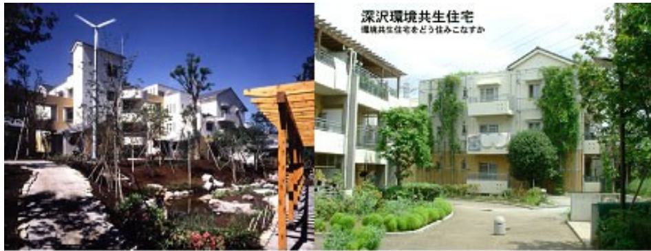
圖 2-1 深澤環境共生住宅
