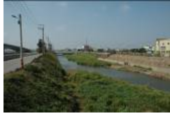
照片 1-3-2 安良港大排水
