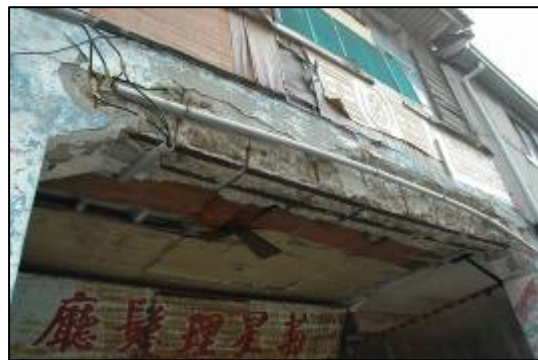
照片 2-2-14 梧棲路 108 號民宅，騎樓鋼筋混凝土樑柱 圖片來源：筆者，2007.03
