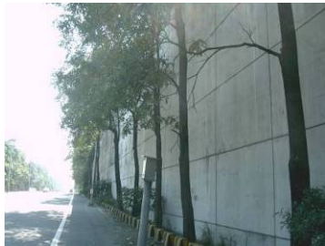
照片 4-16 中化公司所做的防爆牆 圖片來源:研究者拍攝
