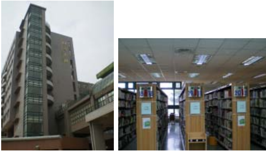
圖 2-56 私立樹德科技大學圖書館外觀及燈具與書架現況
