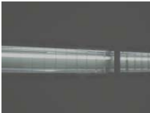
C 燈具使用現況(1)
