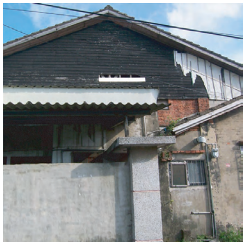
下層磚造，上搭木桁架屋頂的大廠房。
