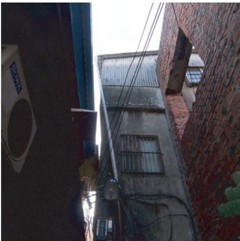
與廠房圍牆卡接的眷村住宅。
