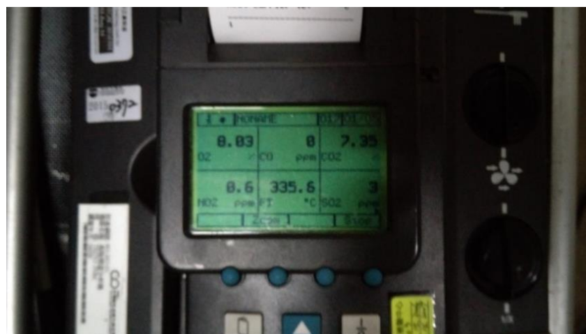
圖 3.10 鍋爐燃燒效率檢測
