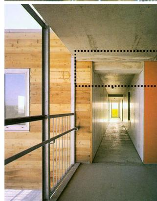
圖 5.1-7 圖 5.1-8 懸挑量體與主建築接合處結構清楚可見（照片中虛框處）
