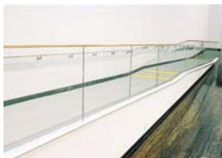
圖 3-1.27 寬度與坡度適中的緩坡，並配置兩種不同高度的扶手（資料來源：靜岡文化藝術大學）
