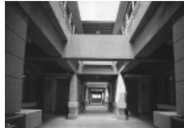
圖 3.1.4：長庚養生文化村，中央內街之挑空處理。《資料來源：台灣建築雜誌，NO.114》
