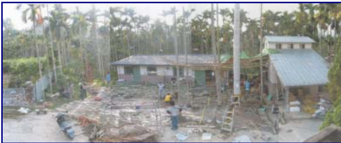
圖 4.2-10 餐廳前施工情形 (資料來源:高雅楓)
