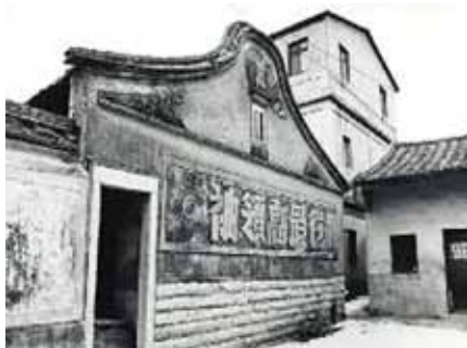
圖 2-7 舊時 20 號倉庫（圖片來源： 台中鐵路局）
