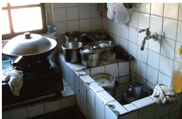
水槽過小且緊鄰瓦斯爐；水槽旁流理台總是放置許多鍋具，造成備餐時沒有空間放置食材。
